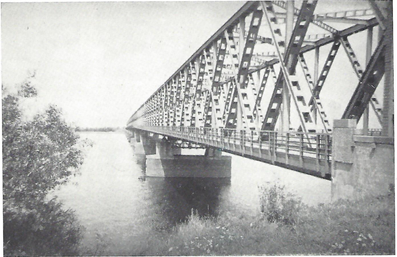
Moerdijkbrug gezien van de Zuidelijke oever
